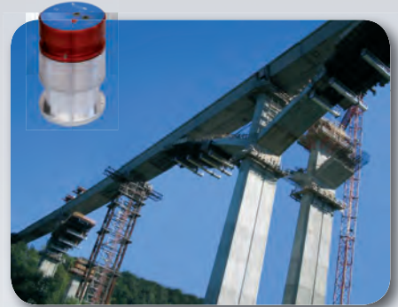
Monitoring of bridges Überwachung von Brücken
